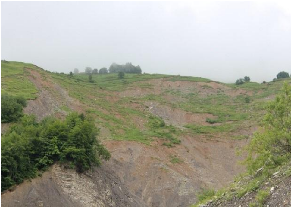
Fig. 2. Landslide areas in Mletiskhevi
